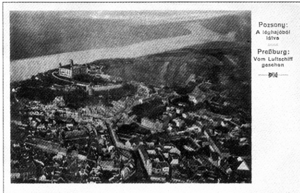
Obr.8 - Z maďarského i nemeckého textu na pohľadnici vyplýva, že tento pohľad na historické jadro Bratislavy sa naskytl z paluby vzducholode
